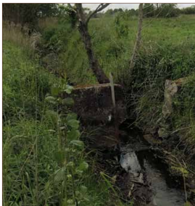
Rycina 4. Przykład zniszczonych zastawek na rowach melioracyjnych
