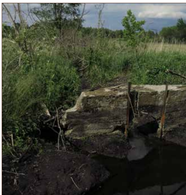
Rycina 4. Przykład zniszczonych zastawek na rowach melioracyjnych
